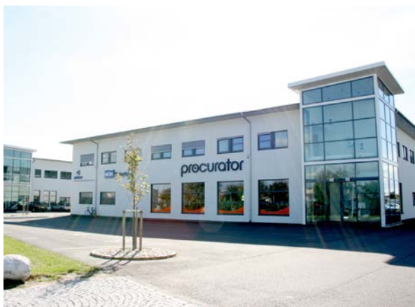
DUBBELKNAPPEN 4, MALMÖ Modern industri- och lagerfastighet med flexibla ytor och tillhörande kontor i populära stadsdelen Fosie.
